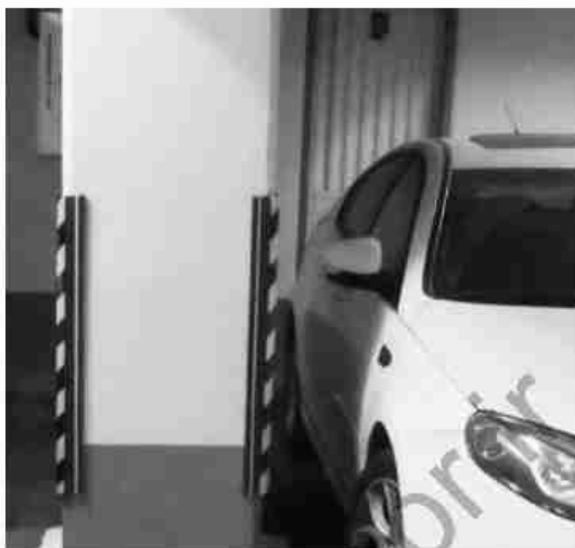
شکل ۲۳-۴-۵: ضربه گیر سر ستون
